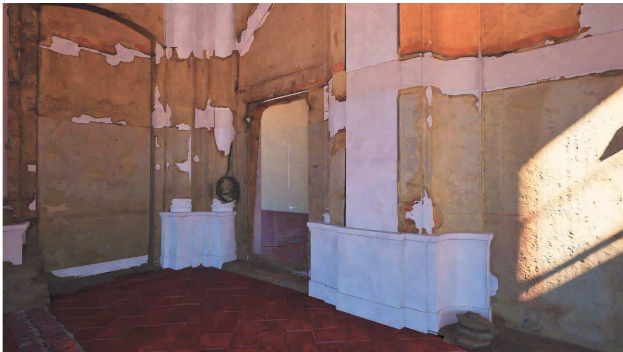
02 | pohled na JV roh se vstupními dveřmi
